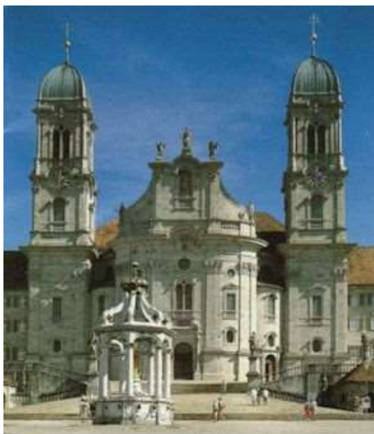
Svizzera - Einsiedeln - Santuario N.S. degli Eremi - La facciata principale
